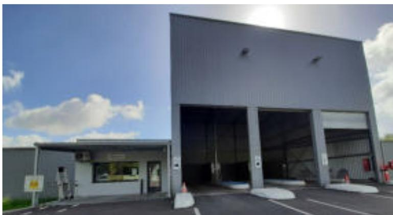
Le quai de transfert situé à Massugas permet le transit des déchets jusqu'à leur acheminement vers les exutoires de traitement. Le pont-bascule équipé d'un portique de détection de radioactivité permet l'enregistrement de tous les passages.
